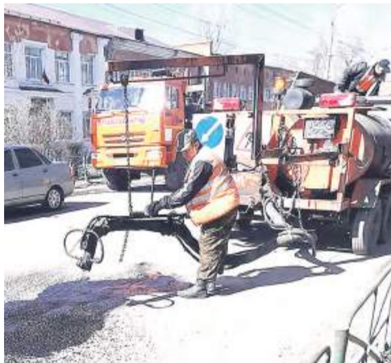
г. Рубцовск. Ямочный ремонт на ул. Комсомольской.
