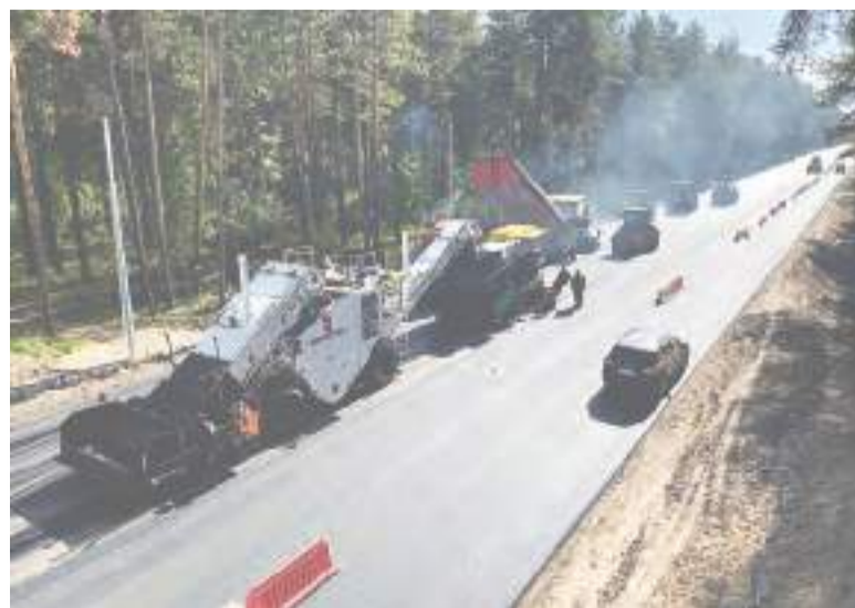
Работы на объездной дороге г. Барнаула.
