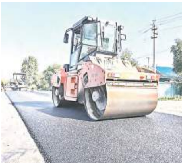
Идет укладка асфальта.
