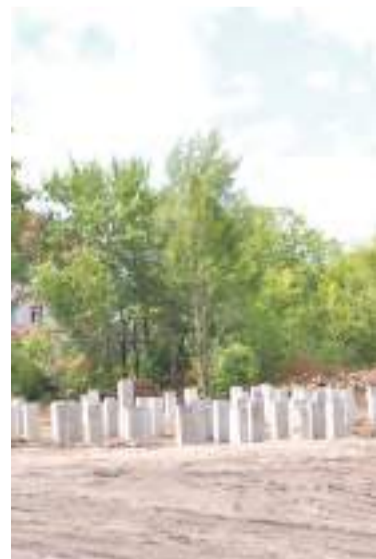
Подготовлено свайное поле.
