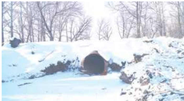
Труба обводного канала.
